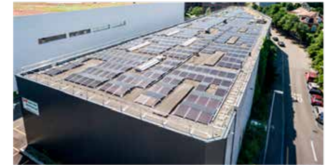
PV-Anlage Marksteiner (ca. 1000 m 2 )
